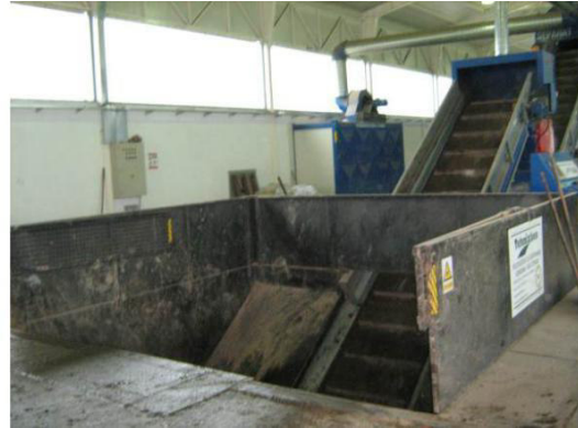
Слика 4.6.3-5. а) Истоваривање мешаног комуналног отпада у прихватну комору; б) прихватна комора са транспортером
