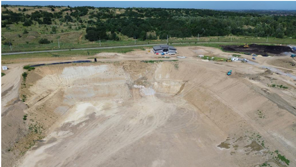
Слика 4.8.1-1. Пресек радова на изградњи тела депоније и управне зграде (август 2024.година)
