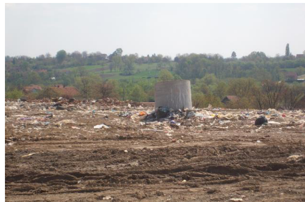
Слика 4.8.3-5. Део уређеног дела тела депоније са биотрном
