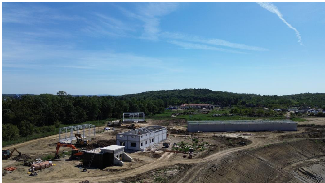
Слика 4.8.1-2. Пресек радова на изградњи објеката на комплексу РЦУО „Каленић“ - I фаза (август 2024.година)
