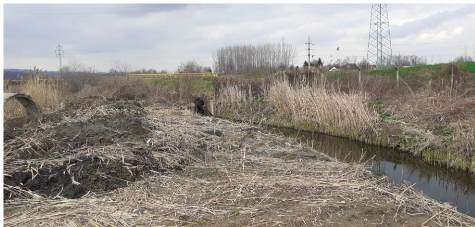
Слика 4.8.14-3: Канал поред депоније за процедурне и отпадне воде
